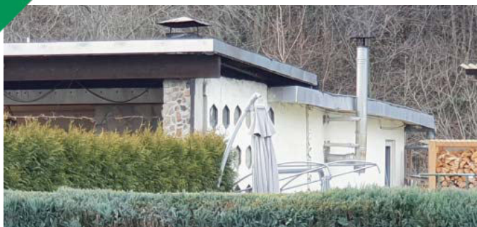
Sowohl der Edelstahlrohrschornstein an dieser Gartenlaube als auch die errichtete Freisitzüberdachung verstoßen offensichtlich gegen das Bundeskleingartengesetz und die Rahmenkleingartenordnung. Hier besteht Handlungsbedarf.
